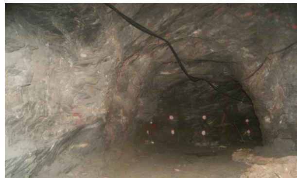
Figura 5. Galeria de instalação do SMDR juntamente com 03 seções de convergência convencionais utilizadas pela Mina Cuiabá
